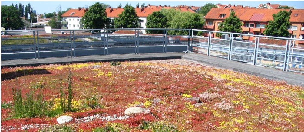
Figur 12. Grönt tak med sedum-örttak Augustenborg, Malmö (Bildkälla: Ramboll, 2016)
